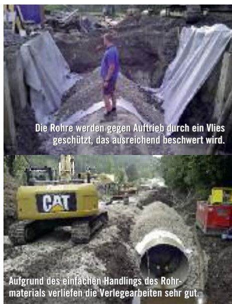
Auch zwei Drittel der gesamten Rohrtrasse musste umpundet werden, damit die GF-UP Rohre DN1700 aus dem Hause Amitech verlegt werden konnten.
