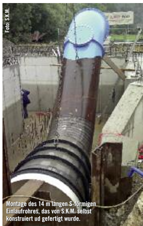
Letzte Arbeiten am Bypass-Rohr im Krafthaus.
