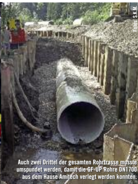
Die Rohre werden gegen Auftrieb durch ein Vlies geschützt, das ausreichend beschwert wird.
