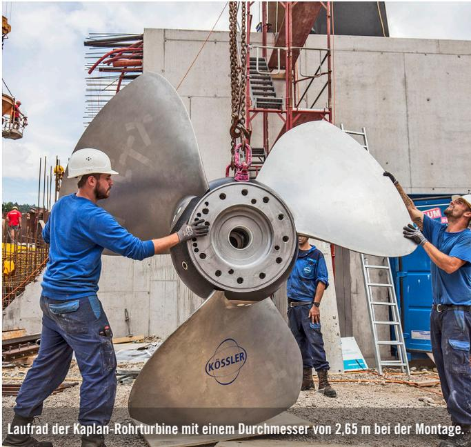
Lauftrad der Kaplan-Rohrturbine mit einem Durchmesser von 2,65 m bei der Montage.
