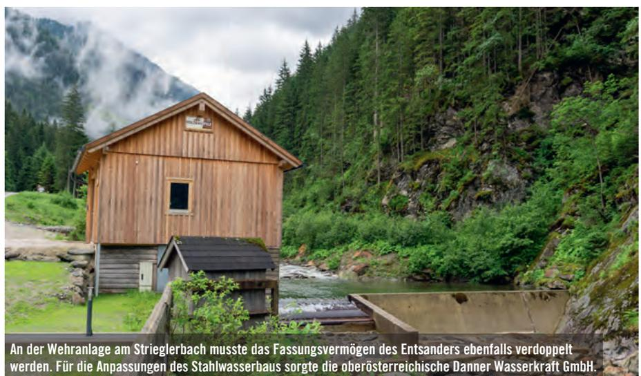
An der Wehranlage am Strieglerbach musste das Fassungsvermögen des Entsanders ebenfalls verdoppelt werden. Für die Anpassungen des Stahlwasserbaus sorgte die oberösterreichische Danner Wasserkraft GmbH.
