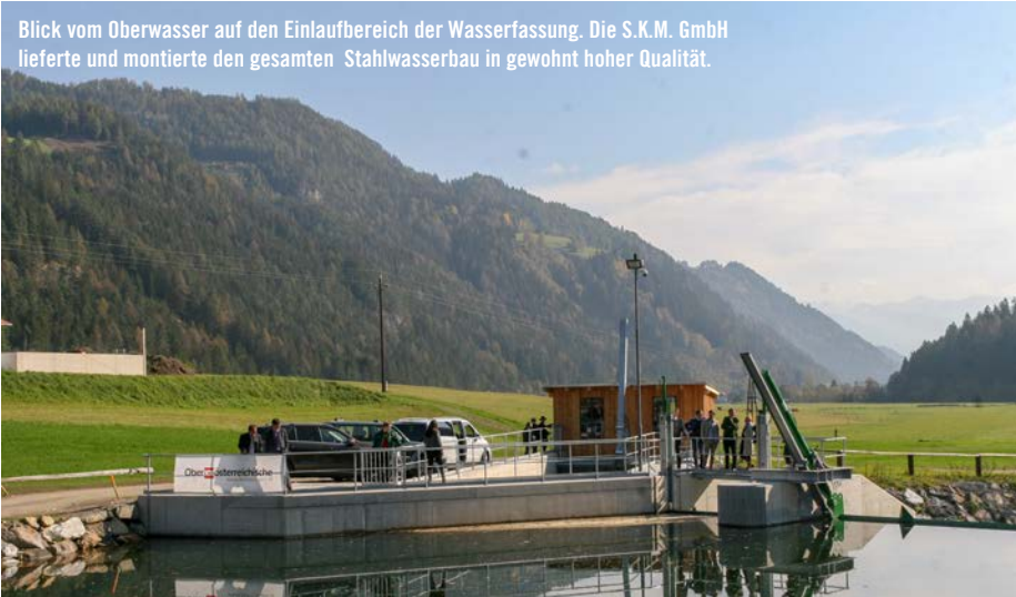
An der Stirnseite des Entsanders in offener Ausführung sorgt ein vertikaler Feinrechen inklusive hydraulischem Rechenreiniger für freien Durchfluss vor dem Beginn der Druckleitung.
