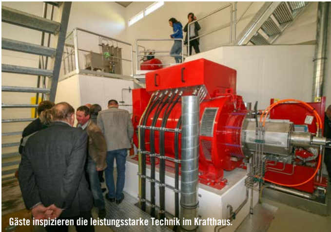
Die für eine ganzjährig hohe Leistung hydraulisch bis ins Detail optimierte Kaplan-Turbine lieferte ANDRITZ Hydro. Im Idealfall kann die doppelt-regulierte Maschine 6 m 3 /s an Ausbaumassermenge nutzen, dabei erreicht sie eine Engpassleistung von 536 kW.
