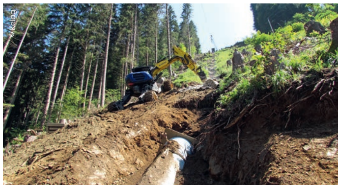
Die Grabungsarbeiten für die Druckrohrverlegung im bis zu 100 Prozent steilen Gelände konnten nur mit einem Schreitbagger erledigt werden.
