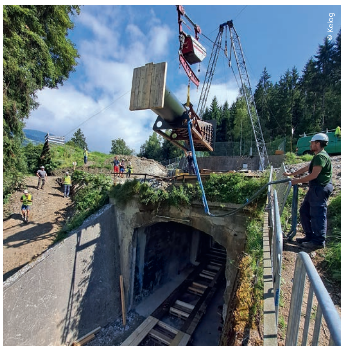
Der neue Einlaufkonus wurde ebenfalls per Materialseilbahn an seinen Bestimmungsort gebracht und vom Team der Kelag selbst montiert.
