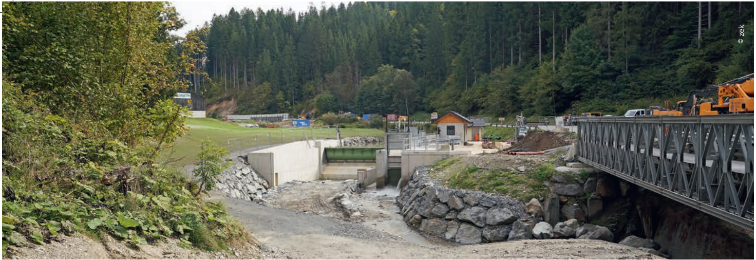
An der neuen Wasserfassung Arriachbach wurde eine 9,50 Meter breite und 1,70 Meter hohe Stauklappe sowie ein Grundablassschütz installiert.
