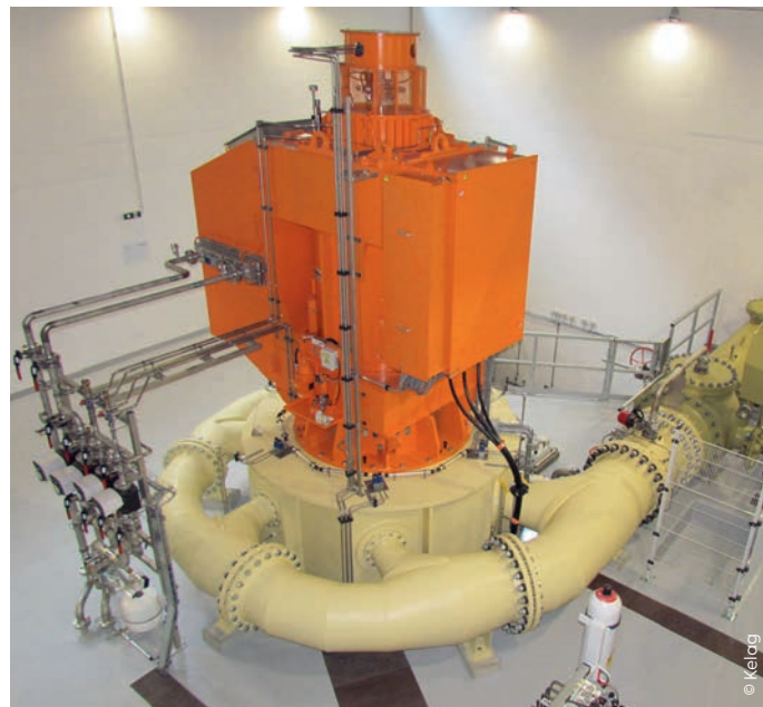
Die 6-düsige Pelton turbine von Voith Hydro treibt einen wassergekühlten Generator (Nidec) an. Die Turbine ist auf 2,4 MW Leistung ausgelegt.
