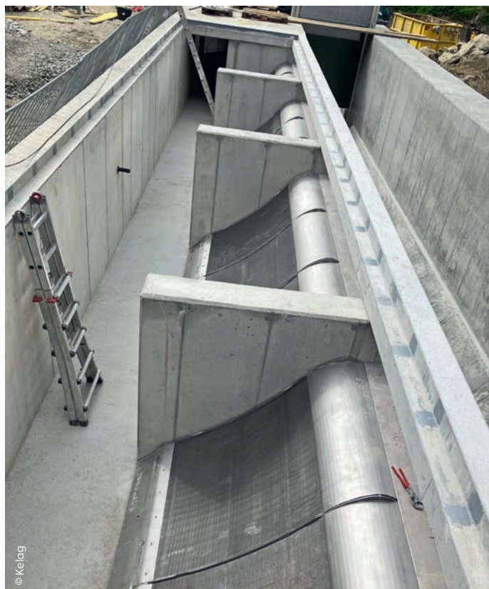
12 Coanda-Module von Wild Metal sorgen im Untergrund für eine effiziente Abscheidung von kleinen Partikeln an der Rechenoberfläche.
