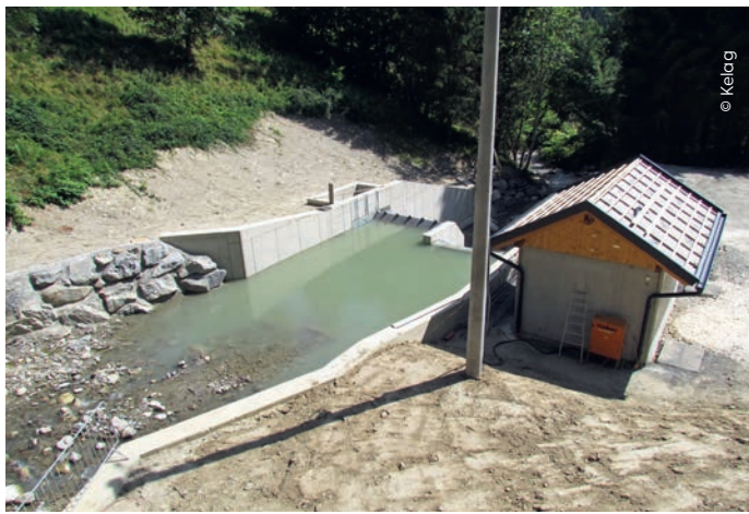
An der Wasserfassung Laastädterbach, der kleineren der beiden Fassungen, können konzessionsgemäß 0,45 m 3 /s eingezogen werden.
