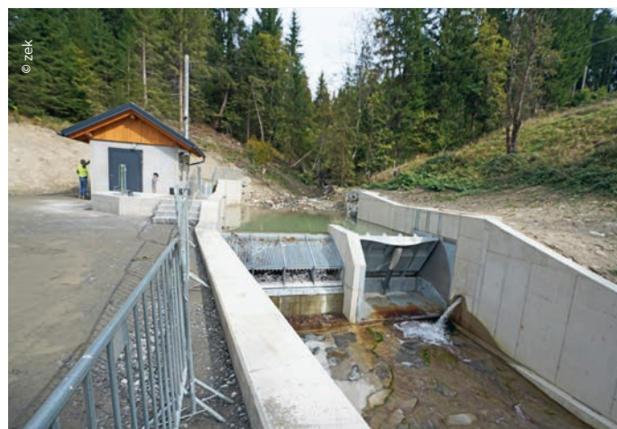
Die neue Wasserfassung Laastädterbach wurde mit einer Stauklappe (4 m x 2 m) und einem Grizzly-System mit Coanda-Rechen ausgerüstet.
