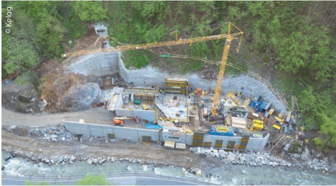
Der Krafthaus-Standort wurde um 8 Meter bergwärts verschoben und eine neue Ufermauer aus stabilem Stahlbeton errichtet.
