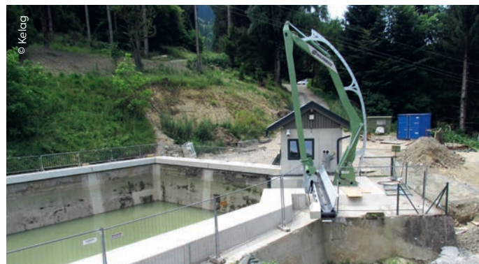
Die neue leistungsstarke Rechenreinigungsmaschine von Wild Metal ist in der Lage, die gesamte Rechenfläche bis 9 m Tiefe zu reinigen.
