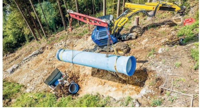
Die 6 Meter langen Rohrschüsse (Fabrikat TRM) wurden mittels Materialseilbahn zur Rohrkünette im Steilhang geliefert.
