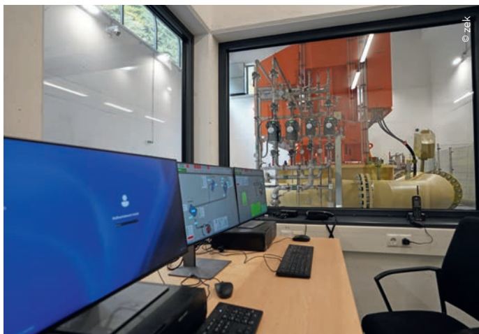
Der steirische Automationsspezialist MGX rüstete das Kraftwerk mit modernster Steuerungs- und Sekundärtechnik aus.
