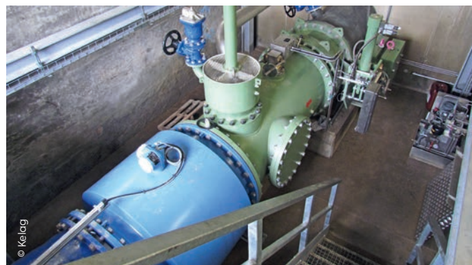
In der Apparatenumgebung wurde eine neue Rohrbruchklappe inklusive IDM eingebaut. Für die Montage wurde eine eigene Krananlage implementiert.
